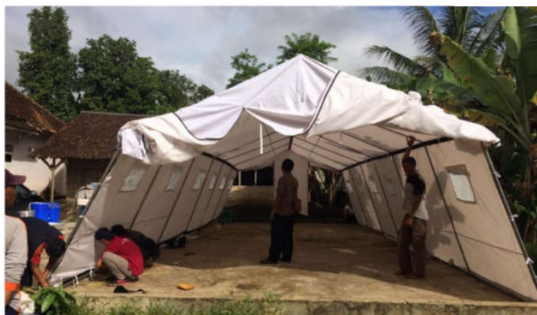
Pendirian Tenda Dapur Umum di Desa Banyumekar Kec Labuan, Pandeglang
