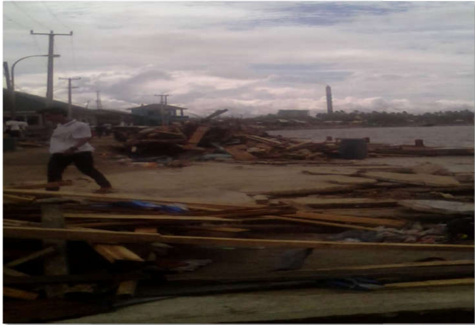
Kondisi kampung teluklabuan, salah satu daerah terdampak bencana
