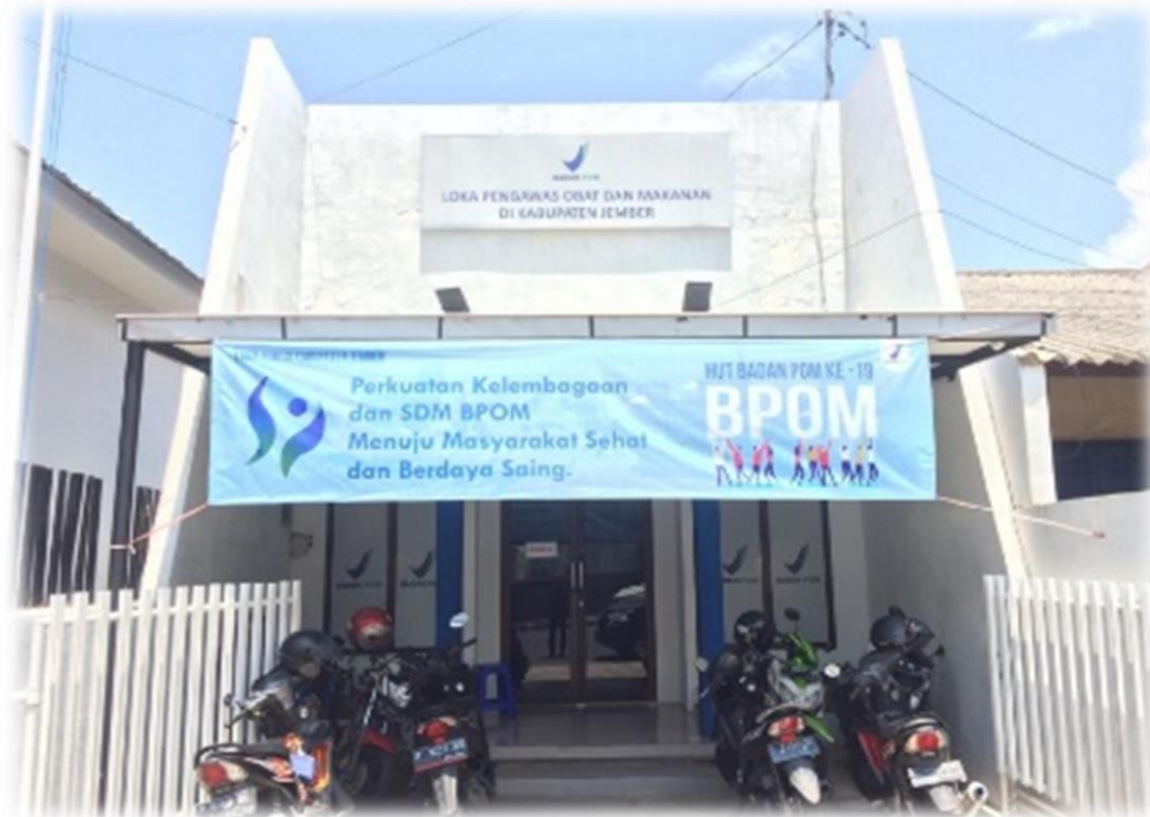
Gambar II.2 Kantor Loka POM di Kabupaten Jember
