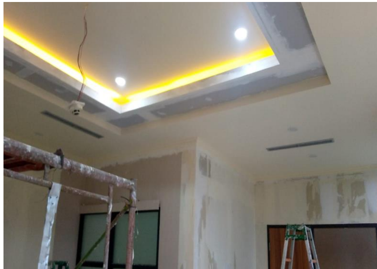
Gambar 3.41 Proses Renovasi Plafond Ruang Direktur Standar Pangan Olahan
