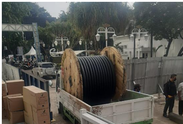
Gambar 3.54 Pengadaan Kabel Feeder Utama Gedung D
