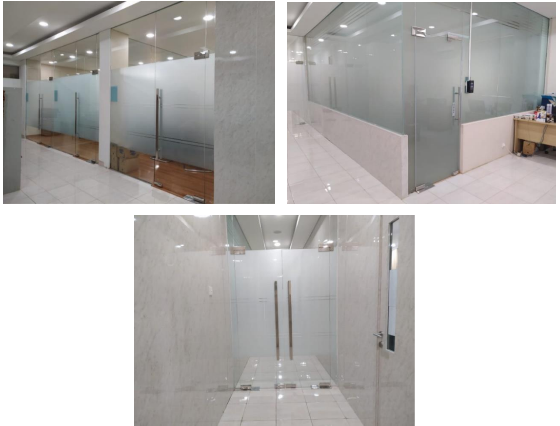
Gambar 3.31 Renovasi Gedung I
