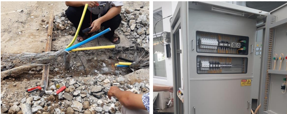
Gambar 3.48 Instalasi panel ATS
