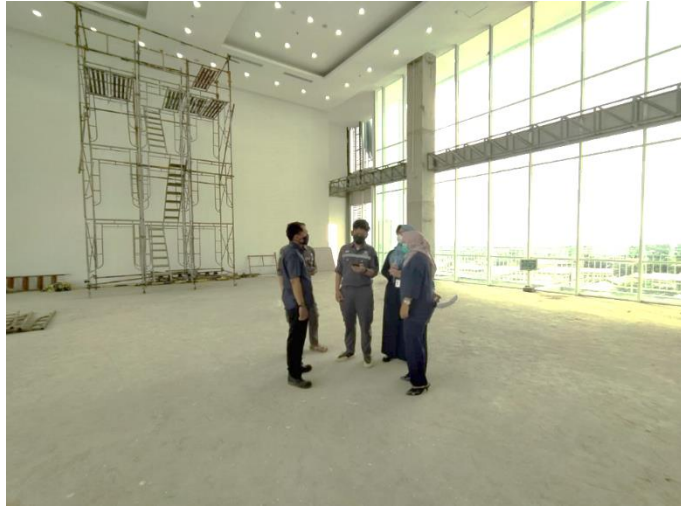
Gambar 3.25 Monitoring proses pemasangan lampu Aula lantai 8 gedung D
