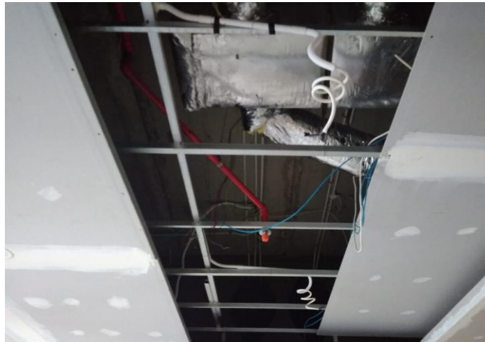
Gambar 3.39 Pasang plafond upceiling & reposisi jalur ducting ac dan splinker
