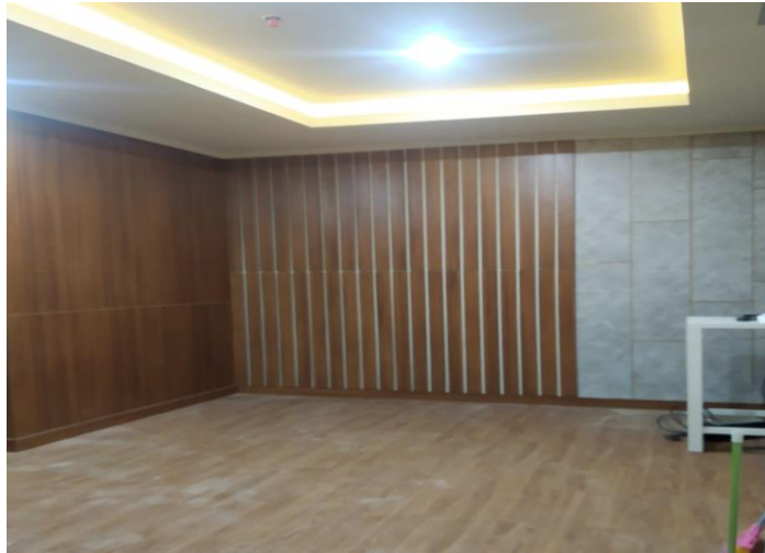
Gambar 3.43 Pemasangan Dinding HPL dan Lantai Vynil
