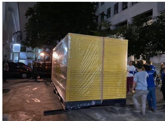
Gambar 3.21 Proses instalasi pemasangan Genset di Lingkungan Badan POM
