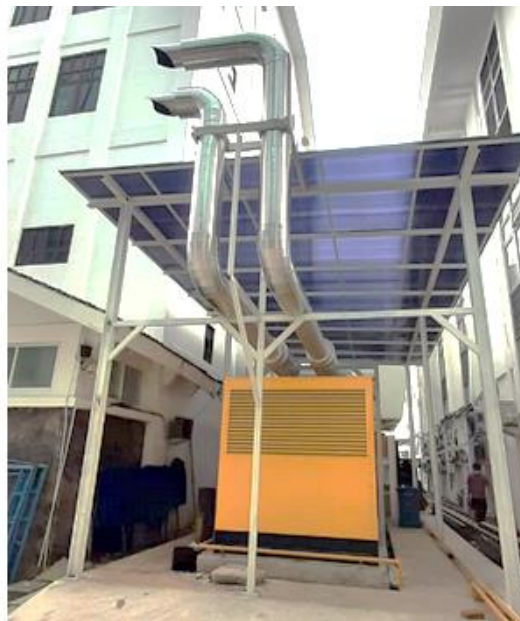
Gambar 3.45 Proses Pengecoran dan Finished Rumah Genset
