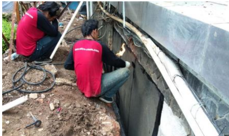
Gambar 3.27 Pemasangan Waterprofing Membran Bakar ruang BPOM command center bagian luar
