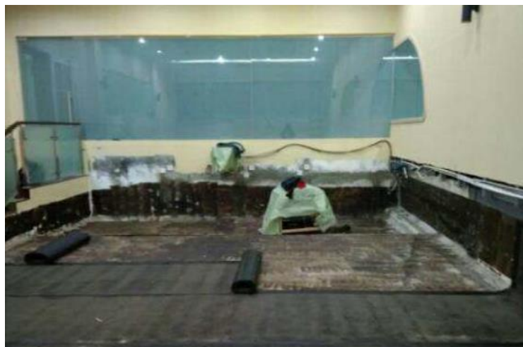
Gambar 3.28 Pemasangan Waterprofing Membran Bakar ruang BPOM command center bagian dalam
