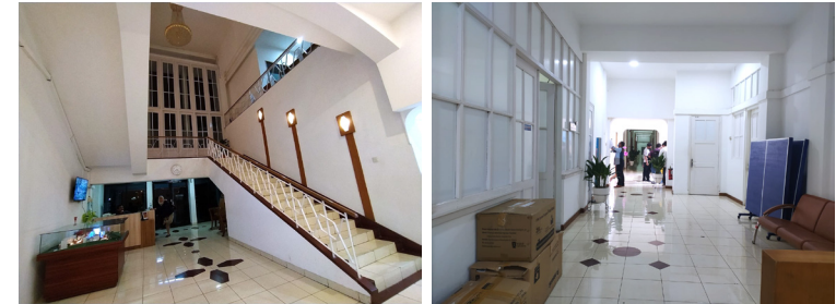
Gambar 3.63. Gedung A sebelum renovasi
