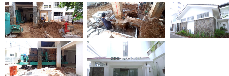
Gambar 3.61. Pekerjaan perkuatan struktur gedung F
